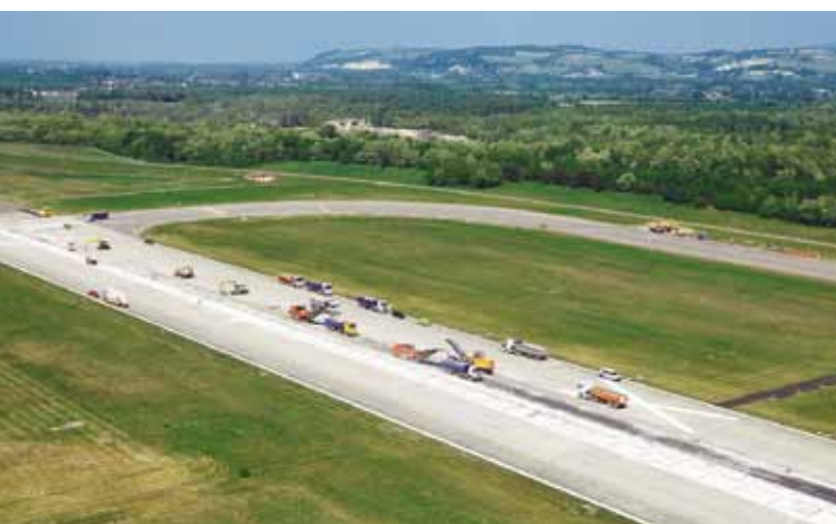
05.2011 Démarrage des travaux principaux sur la piste principale Beginn der Hauptbauarbeiten auf der Hauptpiste Start of main runway works
