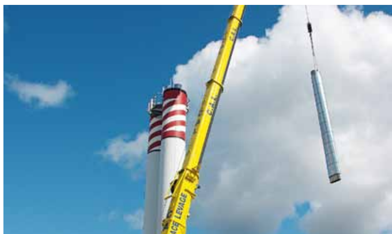
06.2011 Démarrage des travaux de rénovation de la chaufferie centrale Beginn der Instandsetzungsarbeiten an der Heizzentrale Renovation work on the central heating plant begins
