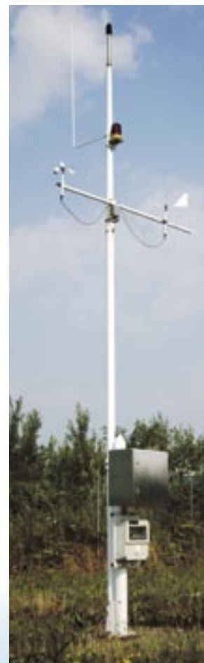
La station de mesure du bruit
