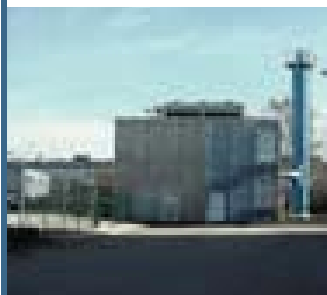
La centrale de cogénération
